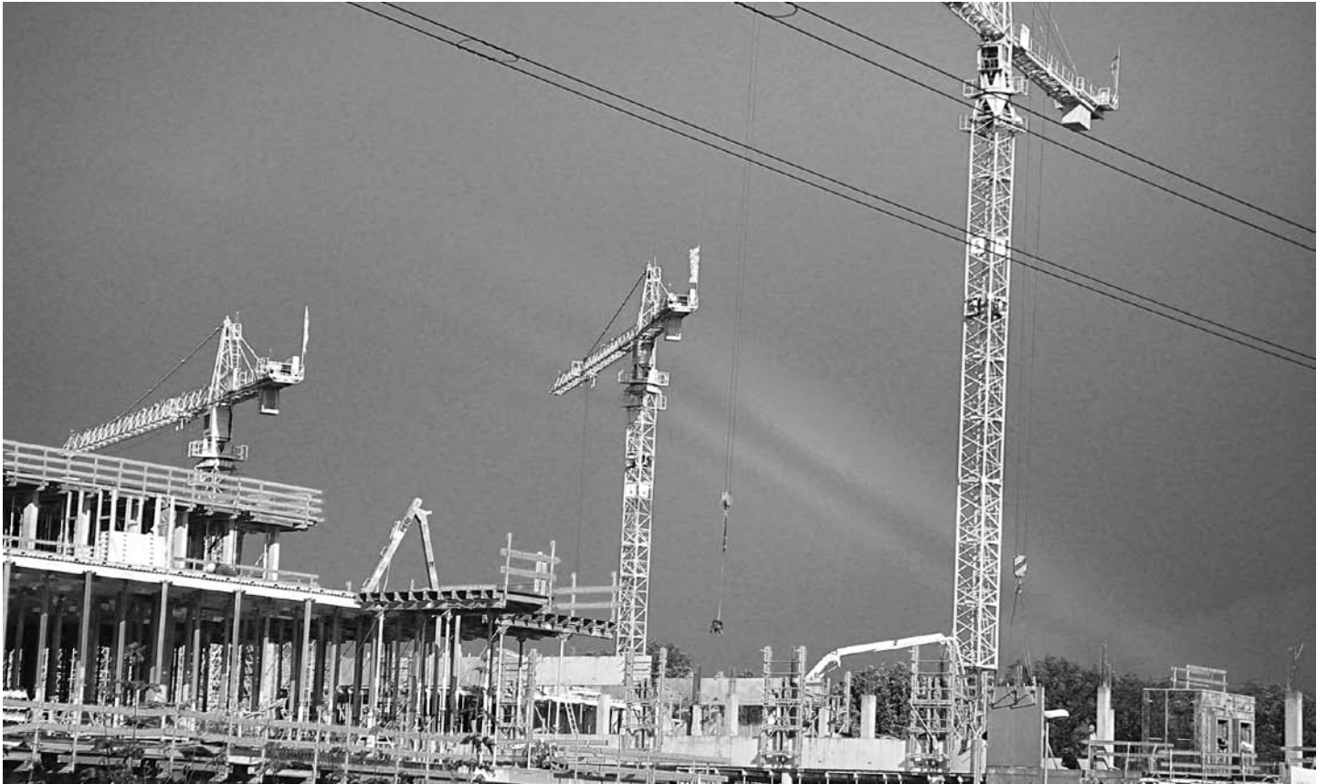
EnBW Baustelle im Juli 2007
