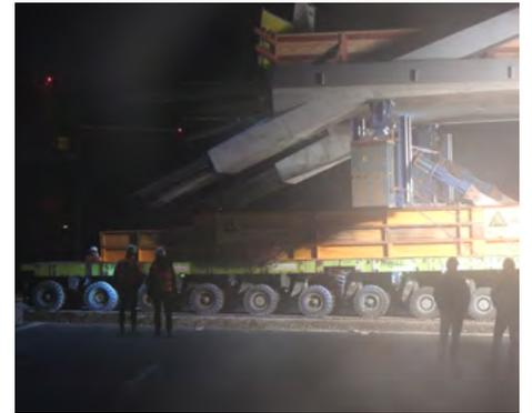
Gegen zwei Uhr nachts war es dann soweit. Die bulligen Motoren, die auf beiden Enden aus jeweils zwei 600 PS starken Schwerlastmodultransporter bestanden, brachten die Brücke langsam aber sicher in Schwung.
